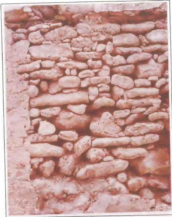
Foto 2.11. 1984 Muur opgebouwd uit koraalsteen. Links is nog een gedeelte van de pleisterlaag te zien. (foto: M. Newton)
